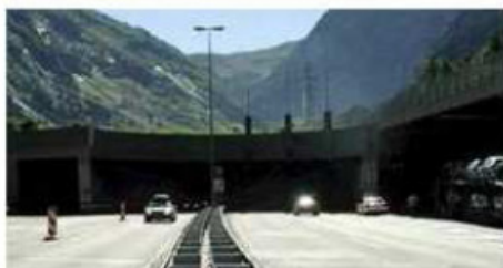
So wenig Verkehr hat es nur ganz selten: Eingang zum Gotthard-Tunnel.
