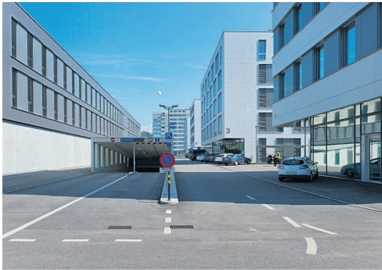
Das Verwaltungszentrum «Neumatt» in Burgdorf haben Private und die öffentliche Hand gemeinsam realisiert. CHRISTOPH RUCKSTUHL / NZF
