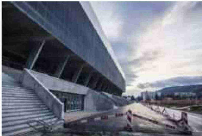
19. Dezember 2014: Die Fassade ist teilweise montiert. Carole Lauener
