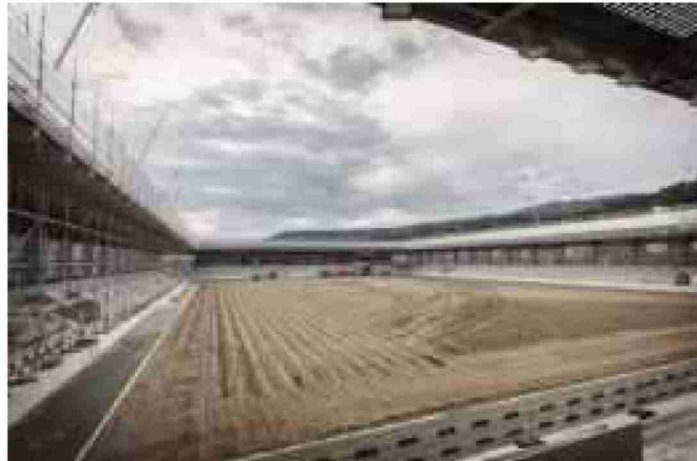
10. Oktober 2014: Noch steht ein Gerüst im Fussballstadion. Tanja Lander
